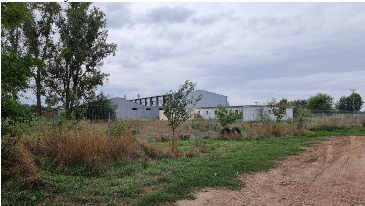
A telephely az állattartó telep felől Forrás: Saját
