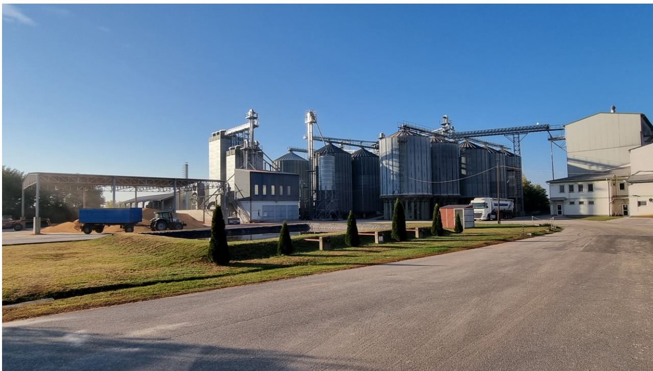
Meglévő, siló, szárító malom Forrás: Saját
